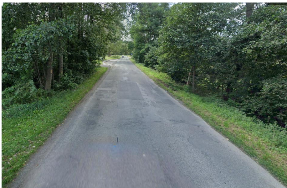
Fot. 2. Droga przed przebudową – źródło: archiwum Starostwa
