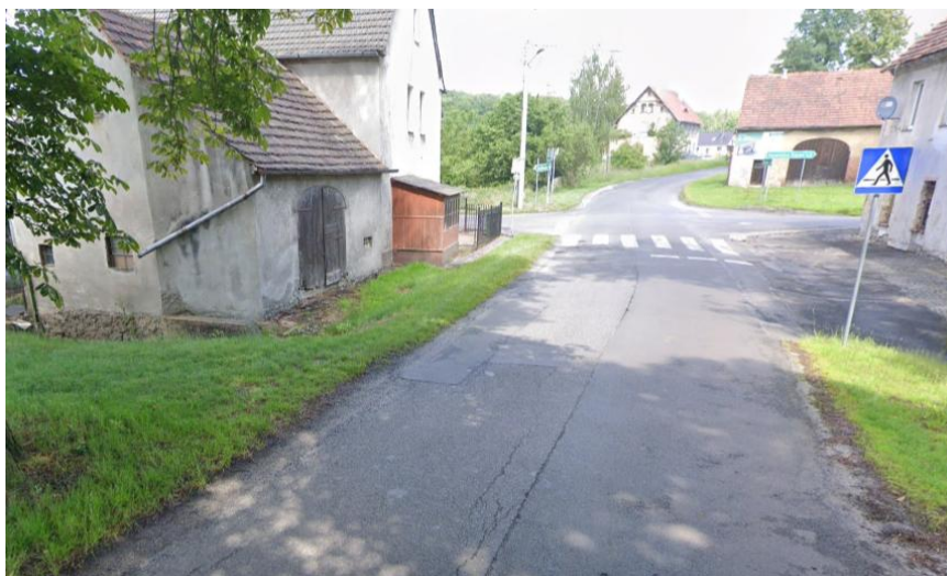
Fot. 5. Skrzyżowanie przed przebudową – źródło: archiwum Starostwa
