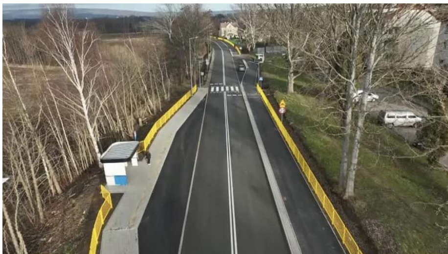
Fot. 3. Droga po przebudowie – źródło: archiwum Starostwa
