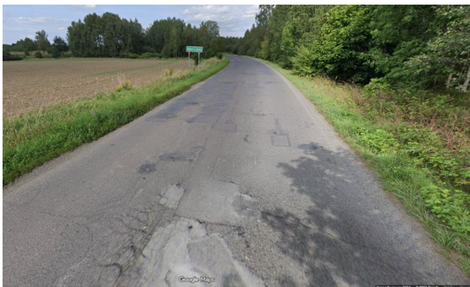
Fot. 1. Droga przed przebudową – źródło: archiwum Starostwa
