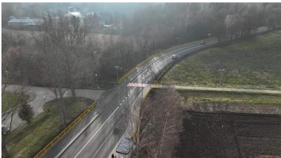
Fot. 4. Droga po przebudowie – źródło: archiwum Starostwa
