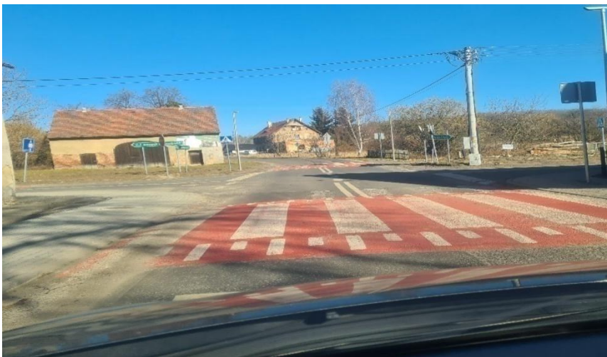
Fot. 7. Skrzyżowanie po przebudowie – źródło: archiwum Starostwa
